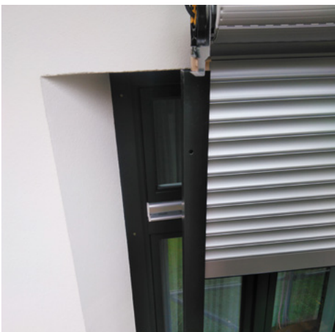
Element bereit zum Einschieben
