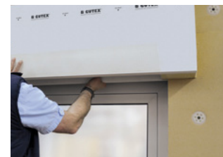
Kasteneinbau nach der Plattenmontage in vorbereitete Öffnung
