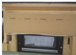
Kasteneinbau während der Plattenmontage
