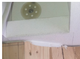
Verschraubung zur Seite mit GUTEX Thermowall® Holzschrauben
