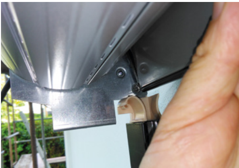
Einfädeln des Rollladenpanzers
